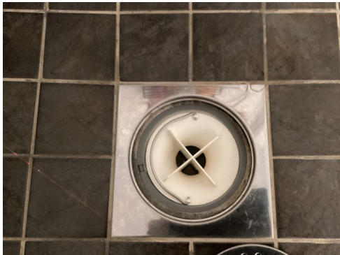
Bilde av sluk.
