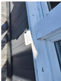
Vinduer og omramming - Vannbord
