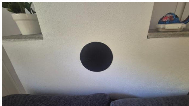
Metallplate ved tettet rørinnføring i pipe.
