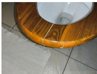
Sanitærutstyr og innredning - Skadet toaletttring
