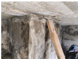
Fundament, grunnmur og gulv mot grunn - Sprekker og symptomer på jordtryksskade
