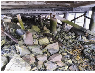
Fundament, grunnmur og gulv mot grunn - Skjevheter i bærende konstruksjon
