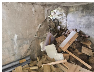
Fundament, grunnmur og gulv mot grunn - Sprekk og skade i grunnmur
