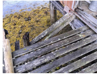
Fundament, grunnmur og gulv mot grunn - Skader i konstruksjon ved ytterdør
