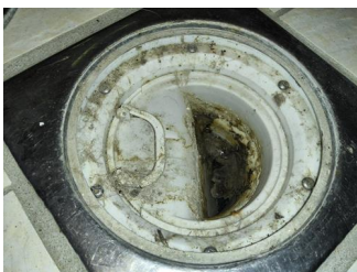
Tettesjiktets tilslutning til sluk - Sluk
