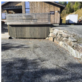
Rekkerkshøyde og lysåpninger - Forstøtningsmur i gårdsplass
