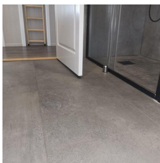
Plassering av sluk og avrenningsmuligheter - Eksempel på høy terskel ved dusj og lav terskel ved dør
