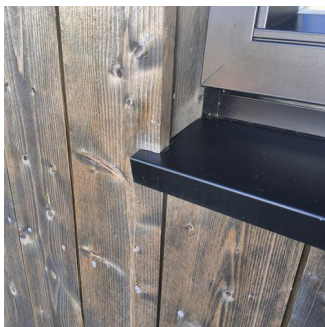
Ytterkledning (fasademateriale, vannbord, utvendig listverk, o.l.) - Eksempel på kledning nær beslag
