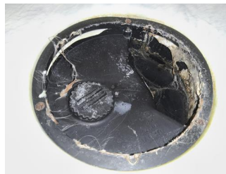
Tettesjiktets tilslutning til sluk - Sluk i dusj
