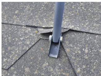
Tekking (med tilhørende beslag) - Skade ved innfestning til takstige
