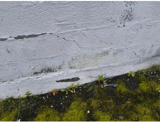
Fundament, grunnmur og gulv mot grunn - Riss og avskalling av murpuss
