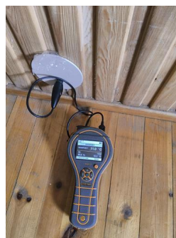
Kontroll i lukkede konstruksjoner - Fuktmåling
