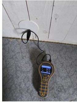
Utført kontroll i tiliggende konstruksjon - Fuktmåling
