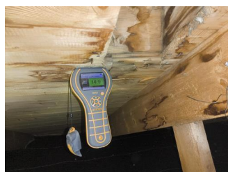
Synlige overflater (taktro, vegger, gulv, o.l) - Fuktmerker med fuktmåling
