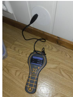
Utført kontroll i tiliggende konstruksjon - Fuktmåling
