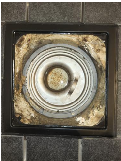
Tettesjiktets tilslutning til sluk - Sluk
