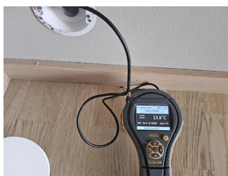
Utført kontroll i tiliggende konstruksjon - Fuktmåling.
