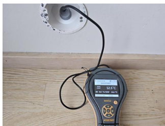
Utført kontroll i tilliggende konstruksjon - Fuktmåling.
