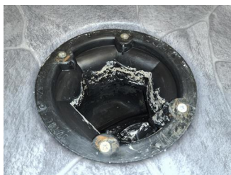
Tettesjiktets tilslutning til sluk - Sluk
