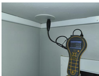
Utført kontroll i tiliggende konstruksjon - Fuktmåling
