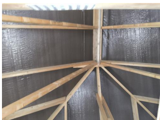
Yttertak og takkonstruksjon - Undertak av presenning
