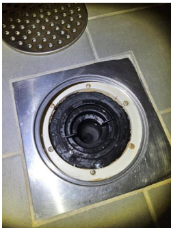
Tettesjiktets tilslutning til sluk - Sluk.
