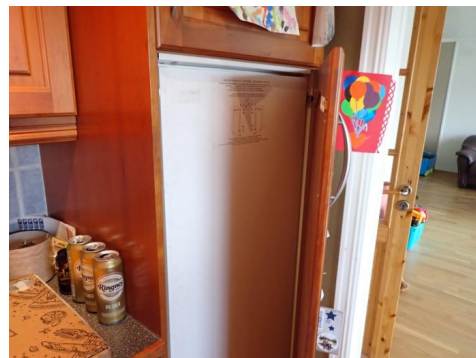
Defekt kobling mellom front og kjøleskap
