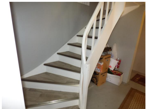
Trapp mellom kjeller og 1.etg
