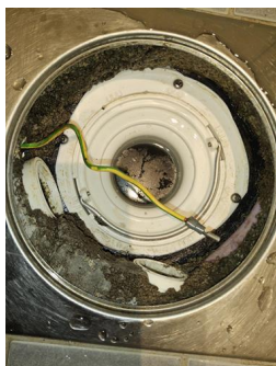
Tettesjiktets tilslutning til sluk - Sluk bad
