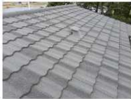
Tekking (med tilhørende beslag) - Taktekking
