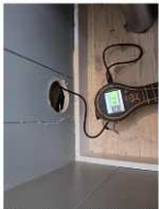
Utført kontroll i tiliggende konstruksjon - Fuktmåling
