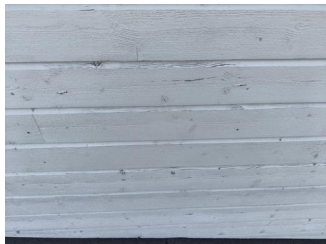
Overflatebehandling - Slitt overflatebehandling
