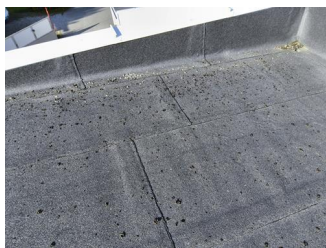
Detaljer inn mot tilstøtende konstruksjoner - Asfaltapp med redusert vedheft til underlag
