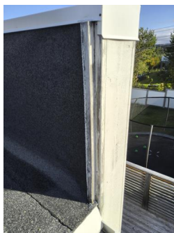
Overflatebehandling - Slitt overflatebehandling
