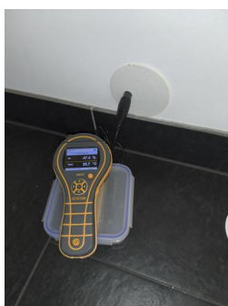
Utført kontroll i tiliggende konstruksjon - Fuktmåling
