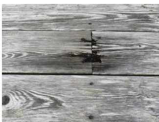
Tilstand på rekkverk og overflatematerialer - Råteskade på terrassebord
