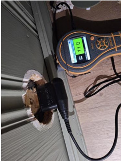
Kontroll i lukkede konstruksjoner - Fuktmåling
