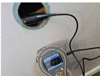
Utført kontroll i tilliggende konstruksjon - Fuktmåling
