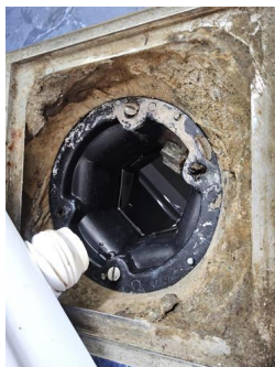
Tettesjiktets tilslutning til sluk - Sluk
