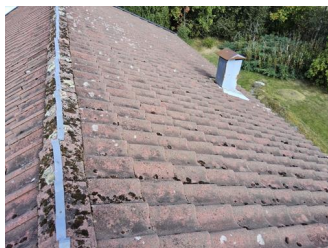
Tekking (med tilhørende beslag) - Taktekking.
