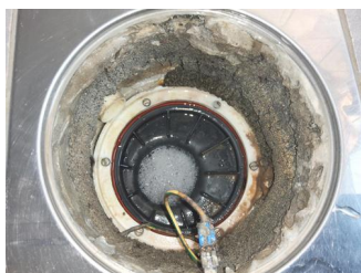
Tettesjiktets tilslutning til sluk - Sluk
