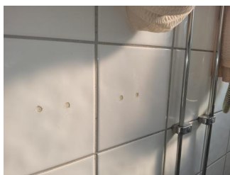
Overflater vegger - Skru hull dusjsone
