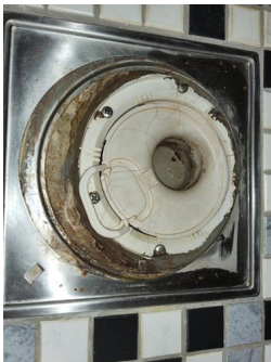
Tettesjiktets tilslutning til sluk - Sluk bad
