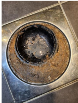
Tettesjiktets tilslutning til sluk - Sluk
