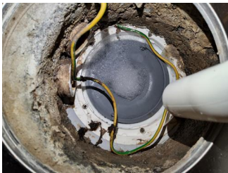
Tettesjiktets tilslutning til sluk - Sluk
