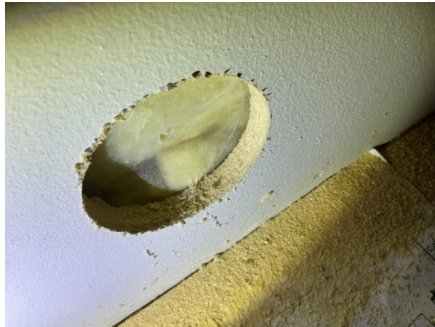
Plastfolie på innside av isolasjon
