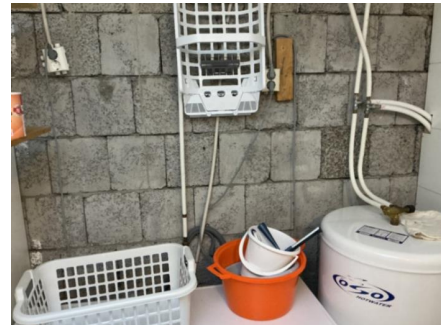
Eksempel på vegg uten tilfredsstillende overflate
