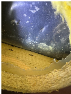
Plastfolie også på utside av isolasjon
