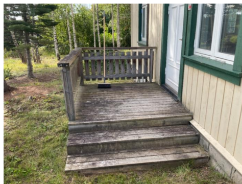
Impregnert tretrapp med platting.
