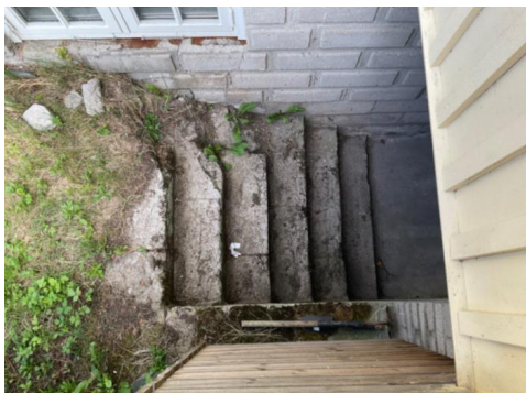
Utvendig støpt trapp til kjeller.
