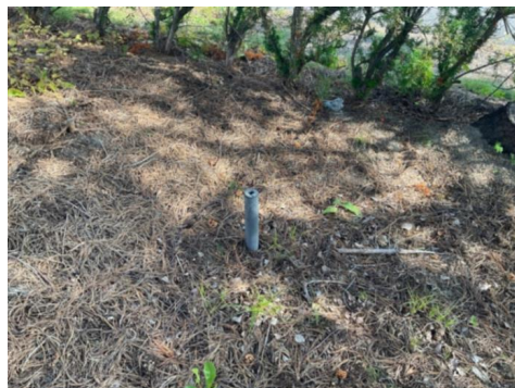
Utvendig vannstoppekran.
