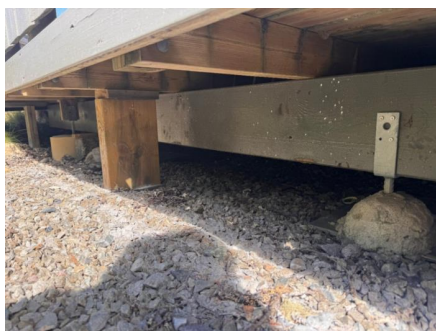
Ufagmessig opplagring av bjelkelag
