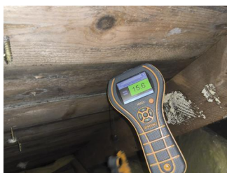
Synlige overflater (taktro, vegger, gulv, o.l) - Fuktmåling
