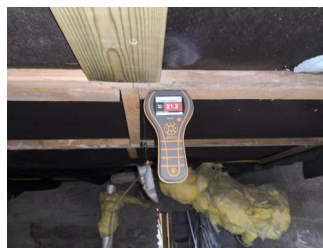
Stikktaking i treverk, fukt og fuktmålinger - Fuktmåling
