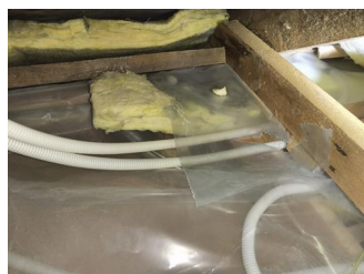
Kontroll av diffusjonssperre - Utetthet i dampsperre
