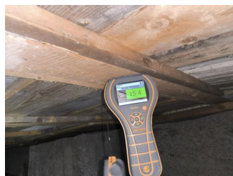
Stikktaking i treverk, fukt og fuktmålinger - Fuktmåling
