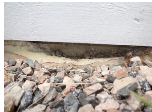
Liten del av utvendig plate og isolasjon er borte.
