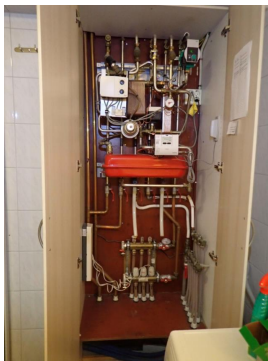
Fordelerskap for fjernvarme, samt rør-i-rør koblinger
