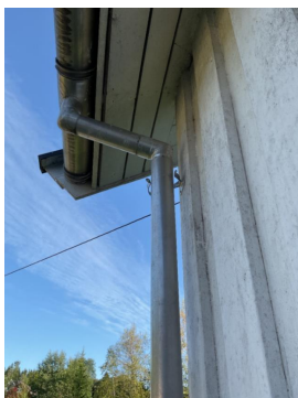
Løse fester og deformasjon på nedløpsrør.
