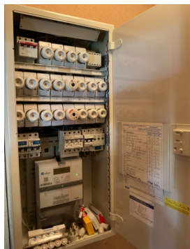
Sikringsskap med automatsikringer.
