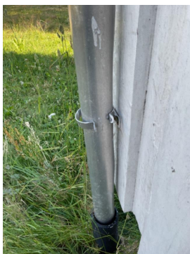
Løse fester og deformasjon på nedløpsrør.
