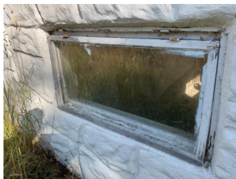
Råteskadede kjellervinduer.
