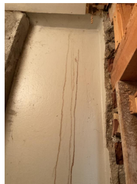
Sotvannmerker langs pipevange.
