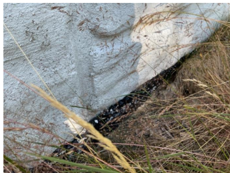
Synlig fuktsikring over grunnmuren.
