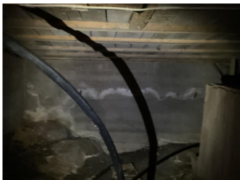
Saltutslag på innvendig mur, dette indikerer fuktvandring i konstruksjonen.
