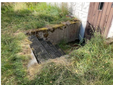
Utvendig trapp til kjeller.
