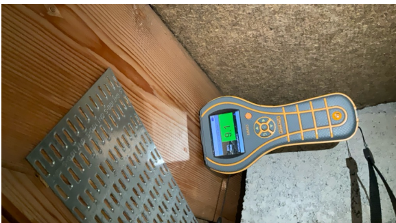
Ved fuktmåling registrerte jeg ikke unormale verdier.
