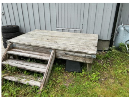
Trapp ved biinngang
