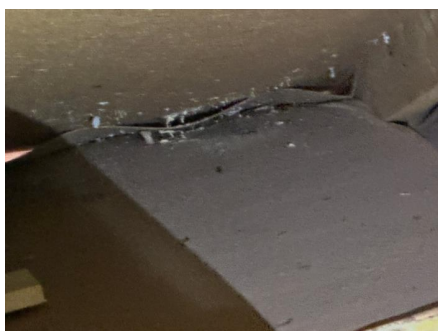
Eksempel på manglende lufting ved raft
