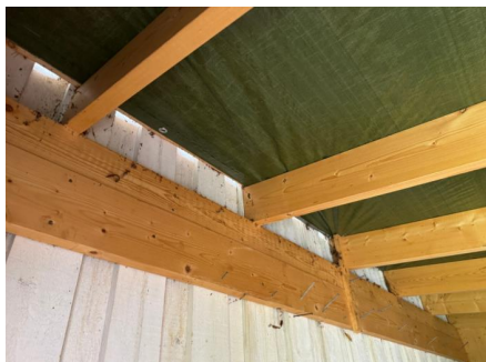
Åpning mellom boligens yttervegg og tak på bod
