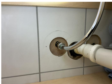
Utetthet i vegg i våtson
