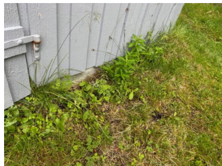
Veggkonstruksjon i kontakt med terreng
