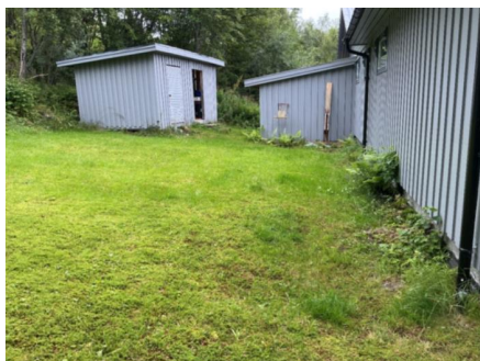
Eksempel avvik på terreng ved bygning
