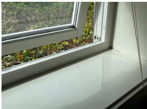
Fuktskadet vindusforing
