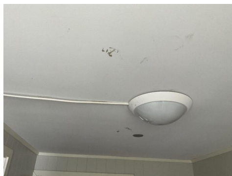
Skader i maling i tak i entre
