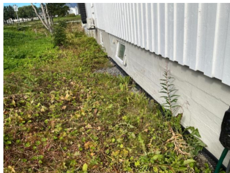
Synlig fuktsikring av mur under terreng
