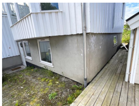
Kjelermur av lettklinkerblokker
