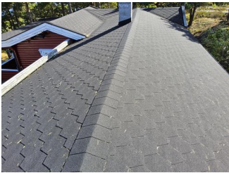
Tekking (med tilhørende beslag) - Taktekking.
