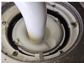
Tettesjiktets tilslutning til sluk - Sluk i bad.
