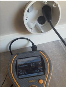
Utført kontroll i tiliggende konstruksjon - Fuktmåling
