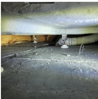
Avløp (inkl. sluk) - Sluk under dusjkabinett
