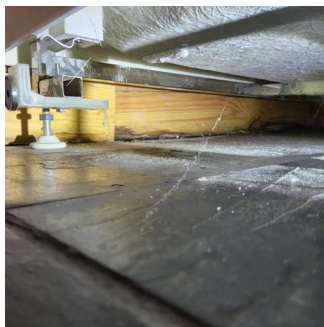
Utført kontroll i tilleggende konstruksjon - Eksempel på fuktmerker i vegg under dusjkabinett
