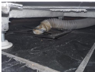
Avløp (inkl. sluk) - Sluk under dusjkabinett
