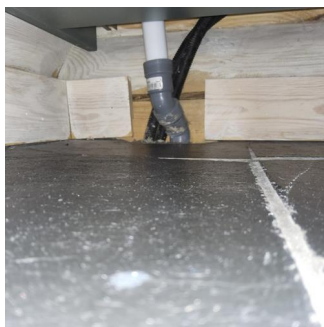
Vanntett sjikt / membran i gulv og vegger - Eksempel på åpninger ved vegg og manglende tettesjikt ved gulv
