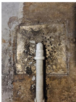
Vanntett sjikt / membran - Sluk i teknisk rom
