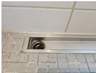
Vanntett sjikt / membran i gulv og vegger - Sluk i bad.
