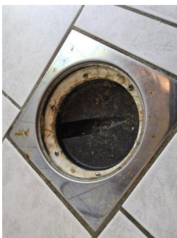
Vannnett sjikt / membran i gulv og vegger - Sluk i bad.
