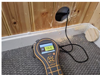
Kontroll i lukkede konstruksjoner - Fuktmåling kjeller.
