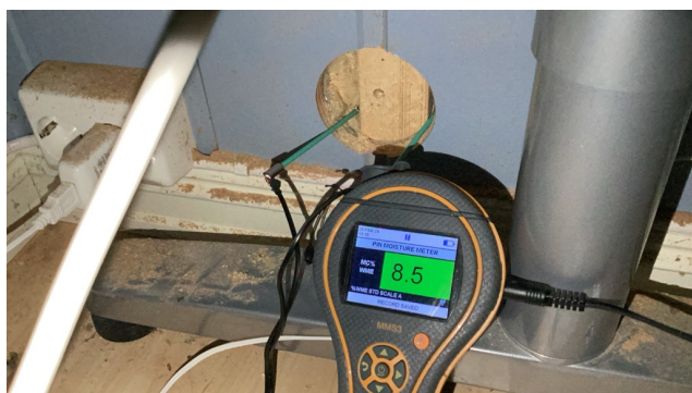
Ingen fuktighet påvist.
