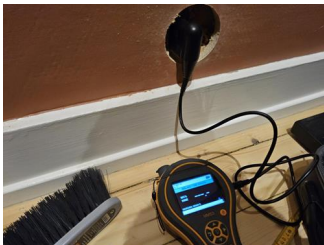
Utført kontroll i tiliggende konstruksjon - Fuktmåling bad.
