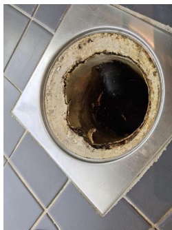
Tettesjiktets tilslutning til sluk - Sluk i bad.
