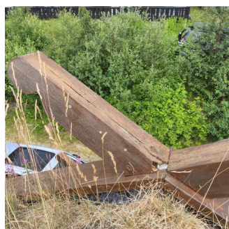
Vannbord, vindskier, gesimskasser og lignende - Eksempel på begynnende råteskade
