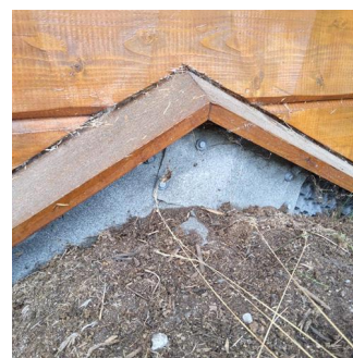
Detaljer inn mot tilstøtende konstruksjoner - Eksempel på tettedetaljer med ufagmessig utførelse
