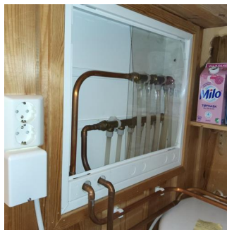
Fordelerskap og fordelerstammer - Fordelerskap for rør-i-rør system plassert i vaskerom
