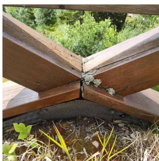
Vannbord, vindskier, gesimskasser og lignende - Eksempel på slitasjer
