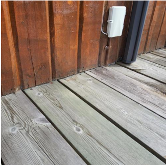
Ytterkledning (fasademateriale, vannbord, utvendig listverk, o.l.) - Eksempel på slitasjer og kledning nær terrassegulv
