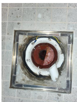
Tettesjiktets tilslutning til sluk - Sluk bad
