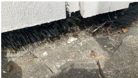
Lav høyde mellom grunn og kledning.
