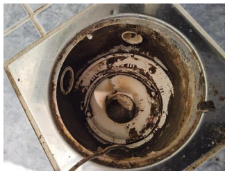
Tettesjiktets tilslutning til sluk - Hovedsluk utenfor dusjsjonen.
