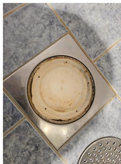
Tettesjiktets tilslutning til sluk - Hjelpesluk i dusjsjonen.
