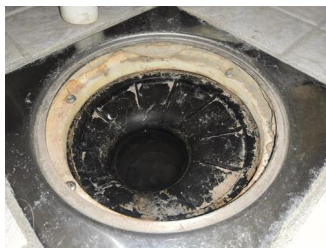
Tettesjiktets tilslutning til sluk - Sluk
