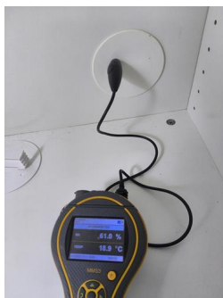
Utført kontroll i tilliggende konstruksjon - Fuktmåling
