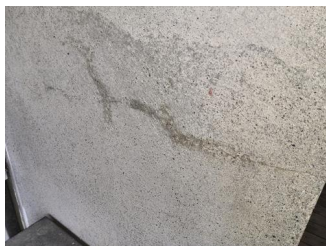
Fasader og konstruksjoner av mur, betong og lignende - Riss i murpuss
