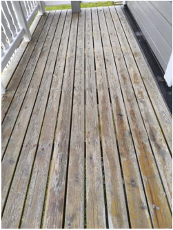
Tilstand på rekkverk og overflatematerialer - Slitasje på terrassebord
