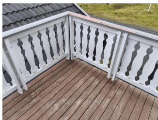
Tilstand på rekkverk og overflatematerialer - Slitasje på terrassebord og rekkverk
