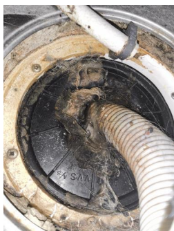
Tettesjiktets tilslutning til sluk - Sluk
