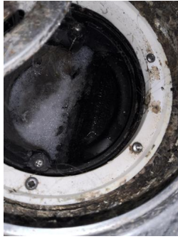
Tettesjiktets tilslutning til sluk - Sluk
