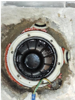
Tettesjiktets tilslutning til sluk - Hovedsluk bad
