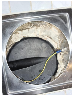
Tettesjiktets tilslutning til sluk - Hjelpesluk bad
