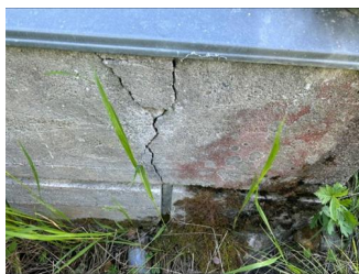
Grunnmur og fundament - -
