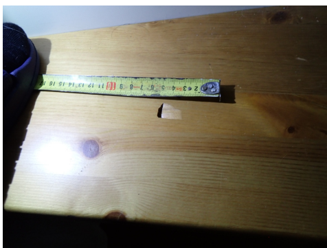
Eksempel på hakk i trinn
