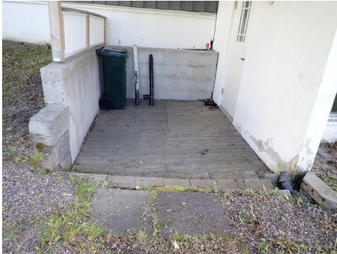
Platting ved kjellerinngang
