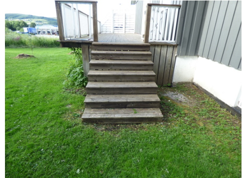
Trapp til veranda
