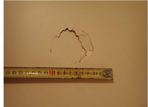
Skade på front på skap i kjeller
