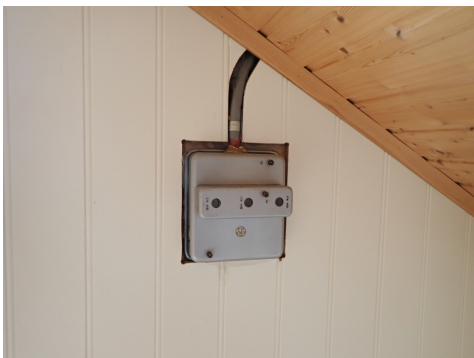
Veggplater lagt rund sikringsboks
