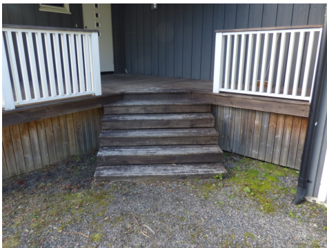
Trapp ved hovedinngang
