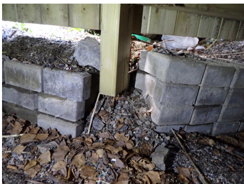
Eksempel på søyle som ikke har bærende effekt
