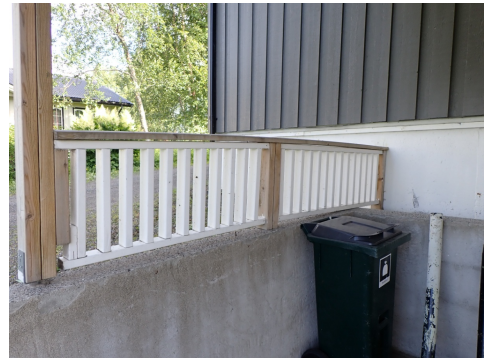
Forstøtningsmur ved kjellerinngang
