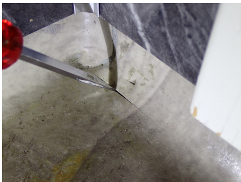
Glipp i belegg, trolig skåret med kniv under legging
