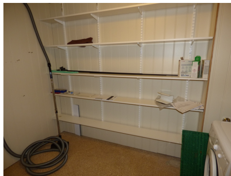
Elfa opphengssystem med hyller
