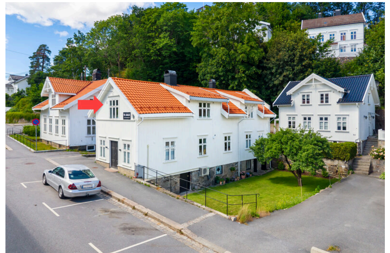
Leiligheten ligger i 2. etg. i bygget.
