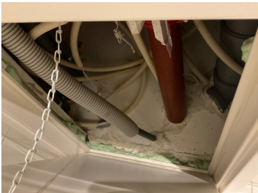
Inne i sjakt er det utildekket isopor.
