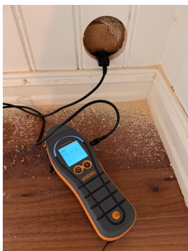
Fuktmåling i tilliggende konstruksjon.
