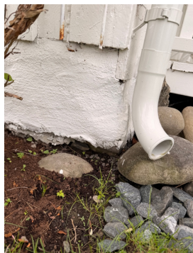
Grunnmuren har avskallinger mot terreng.
