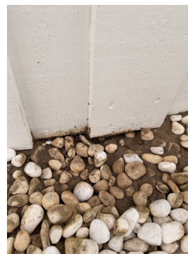
Mauraktivitet oppunder og rundt nedre kant på kledning.
