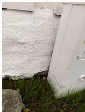
Grunnmuren har avskallinger mot terreng.
