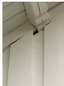
Mauraktivitet oppunder og rundt nedre kant på kledning.
