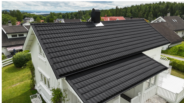
Oversiktsbilde av taktekingen.
