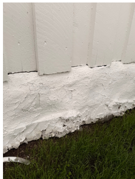
Utvendig overflatebehandling av grunnmuren flasser.
