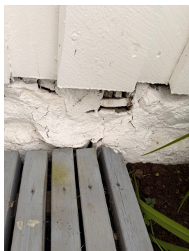
Utvendig overflatebehandling av grunnmuren flasser.
