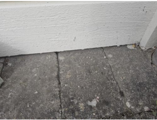
Ytterkledning (fasademateriale, vannbord, utvendig listverk, o.l.) - Kledningen har stedvis kort avstand til terrenget.
