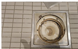
Tettesjiktets tilslutning til sluk - Sluk i dusjsonen.
