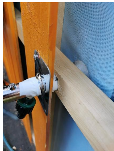
Ingen lekkasjer avdekket ved utekran som kan ha forklaring på fukt.
