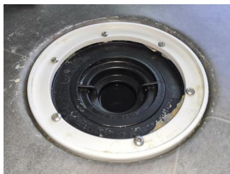
Tettesjiktets tilslutning til sluk - Sluk
