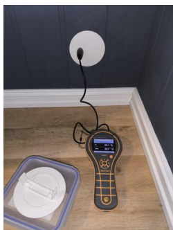
Utført kontroll i tiliggende konstruksjon - Fuktmåling
