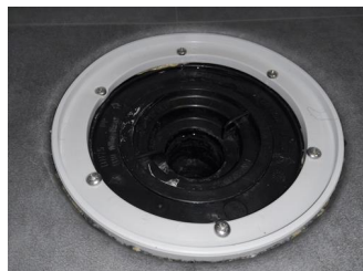
Tettesjiktets tilslutning til sluk - Sluk
