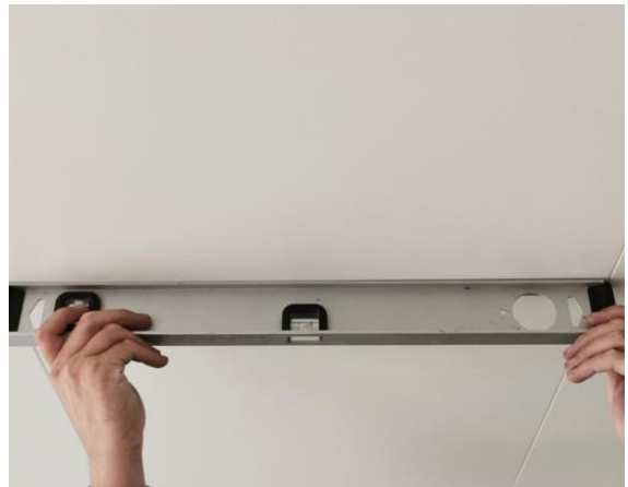
Sjekk med vater. Takplater buer seg noe.
