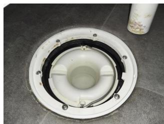
Tettesjiktets tilslutning til sluk - Sluk
