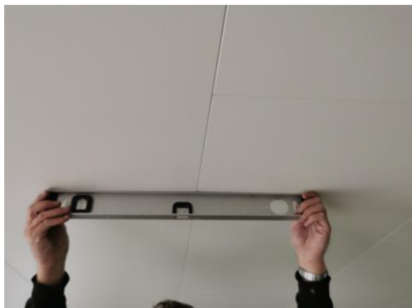
Kontroll ved skjøt
