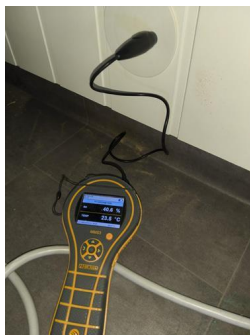
Utført kontroll i tilliggende konstruksjon - Fuktmåling
