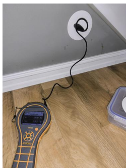
Utført kontroll i tilliggende konstruksjon - Fuktmåling
