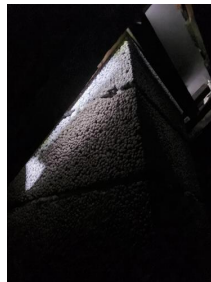
Skorsteiner (over tak) - Dagslys er synlig inne på kaldloft.
