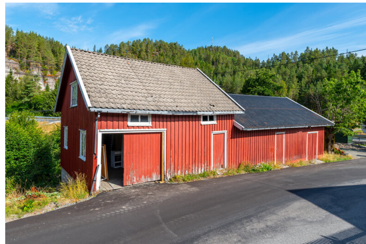
Frittstående garasje/uthus. Garasjen er innholdsrik med god lagringsplass, innredet rom og stor garasje med god takhøyde.
