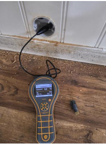
Kontroll i lukkede konstruksjoner - Fuktmåling
