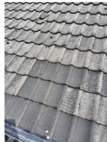
Tekking (med tilhørende beslag) - Knekte takstein
