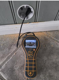
Utført kontroll i tilliggende konstruksjon - Fuktmåling
