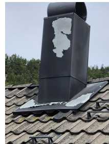
Skorsteiner (over tak) - Pipe
