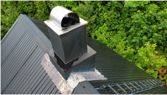
Pipebeslag og fastmontert takstige
