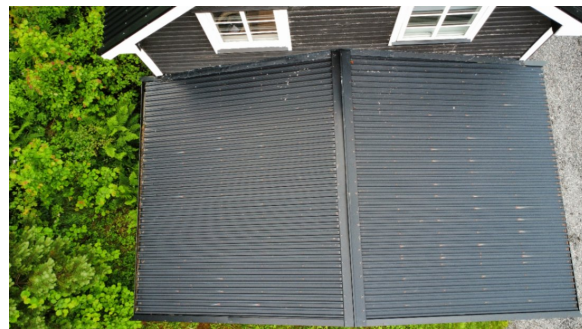
Oversikt tak over veranda
