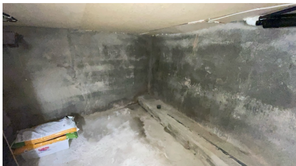
Oversikt grunnmur fra lagerrom mot terreng
