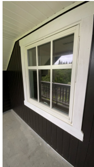
Vindu med 2-lags glass på soverom 3 under tak er fra 2009.
