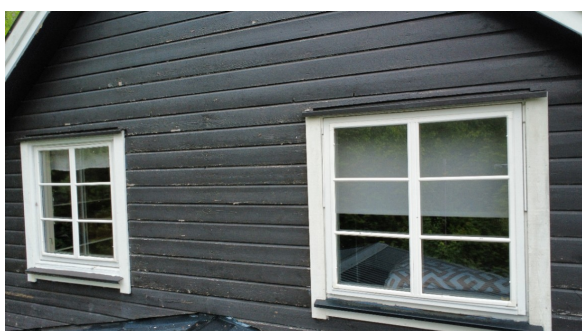
2-lags vindu på soverom/garderober fra 1972 2-lags vindu på soverom 2 av ukjent alder
