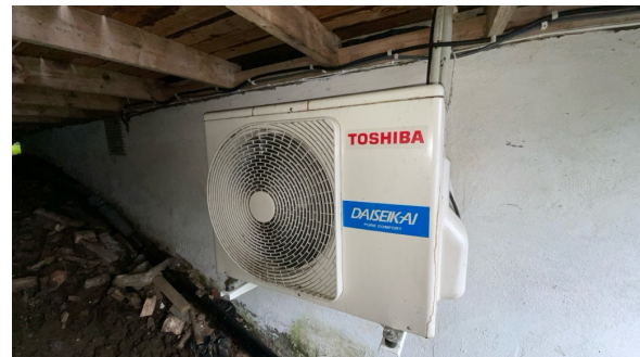
Ytterdel er plassert under overbygd veranda
