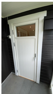
Verandadør i 2. etasje med 2-lags glass fra 2011.
