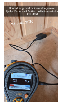
Kontroll av gulvlist på innforet lagerrom i kjeller. Det er målt 24,6 %. Hulltaking er derfor ikke utført.
