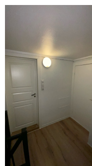
Dør til bad og soverom sett fra gang i 2. etasje
