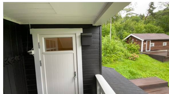
Skjøteledning fra stikkontakt opp til uthus.
