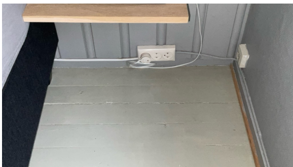
Ufaglært arbeid ved montering av kontakter på soverom
