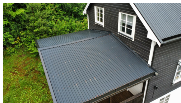
Oversikt tak over veranda
