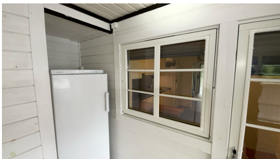
2-lags vindu på kjøkken fra 2007
