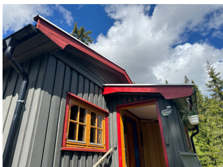
Lukket takkonstruksjon over gang
